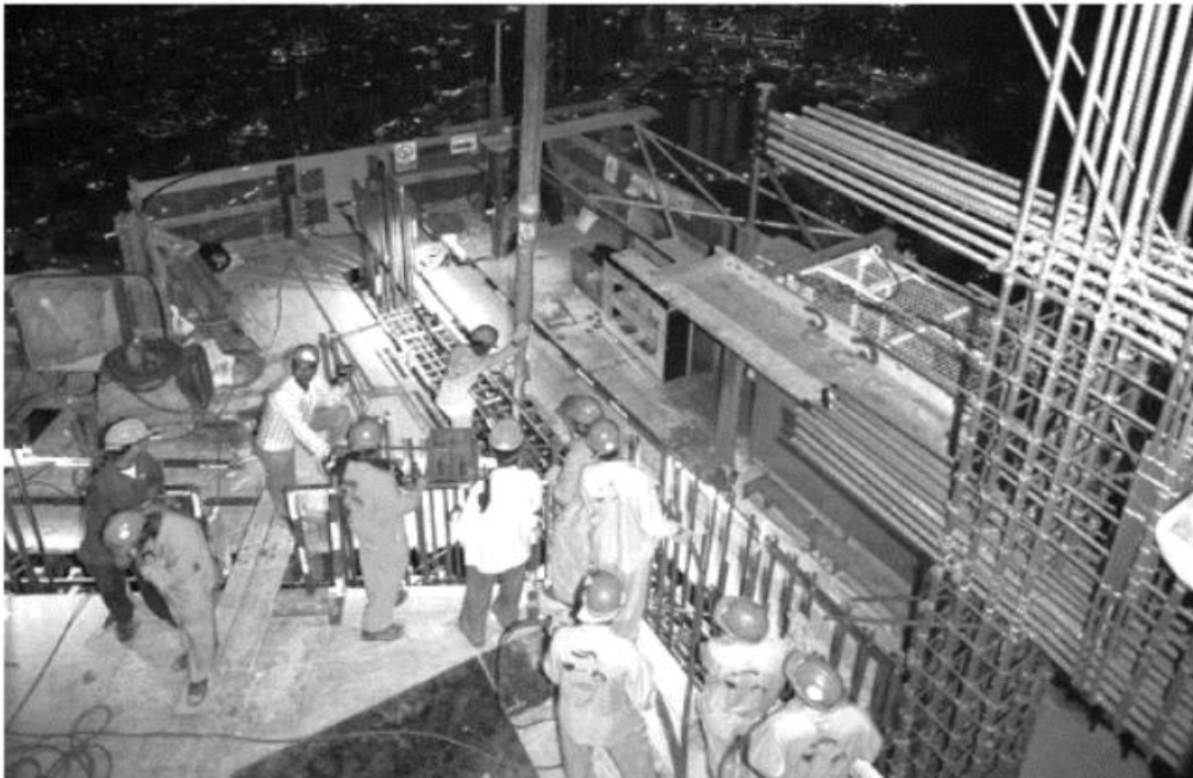
شبکه های متراکم آرماتور در برج خلیفه
