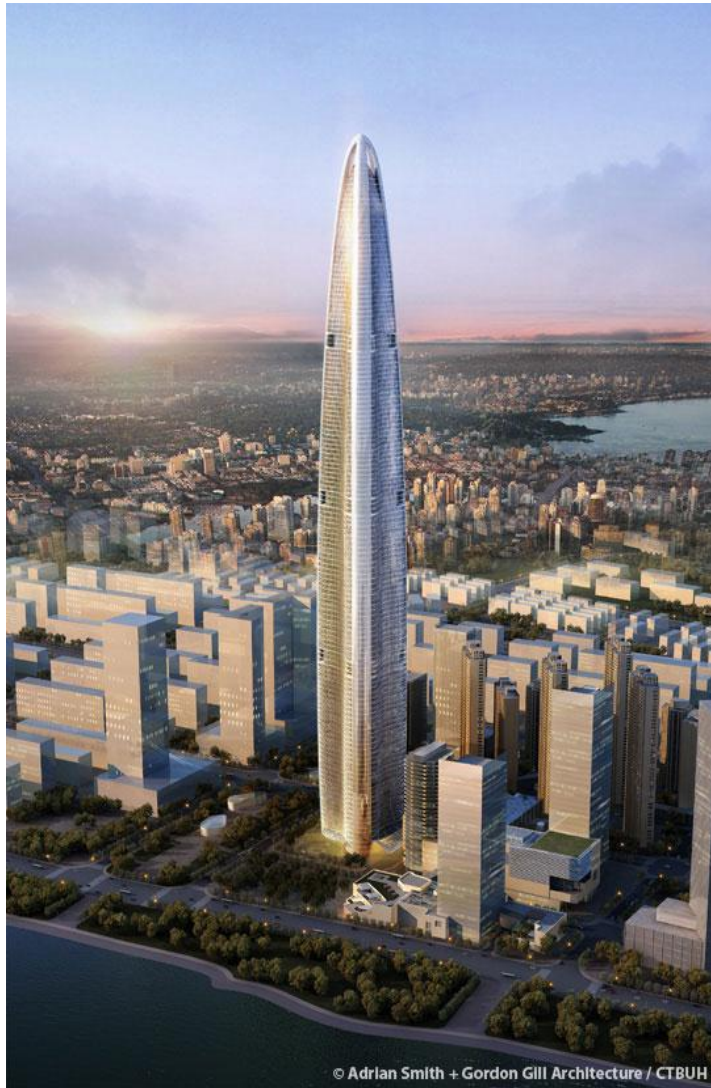
برج Wuhan Greenland Center
